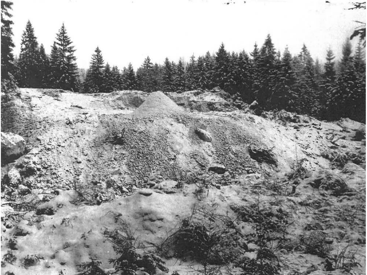
Zustand des Platzes bei Übernahme der Arbeiten am 13. Mai
